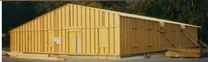
Und schon steht der Rohbau in Holzrahmenbauweise
