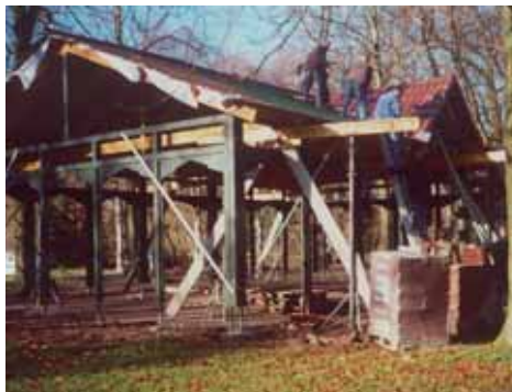
Fleißige Helfer beim Bau der offenen Schützenhalle
